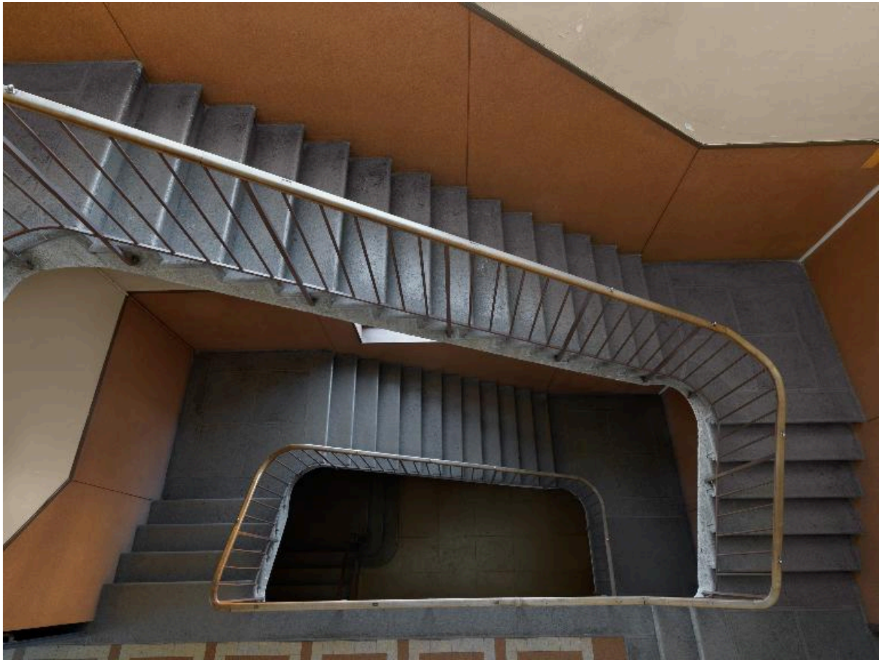
Bâtiment principal : cage d'escalier, depuis le haut
