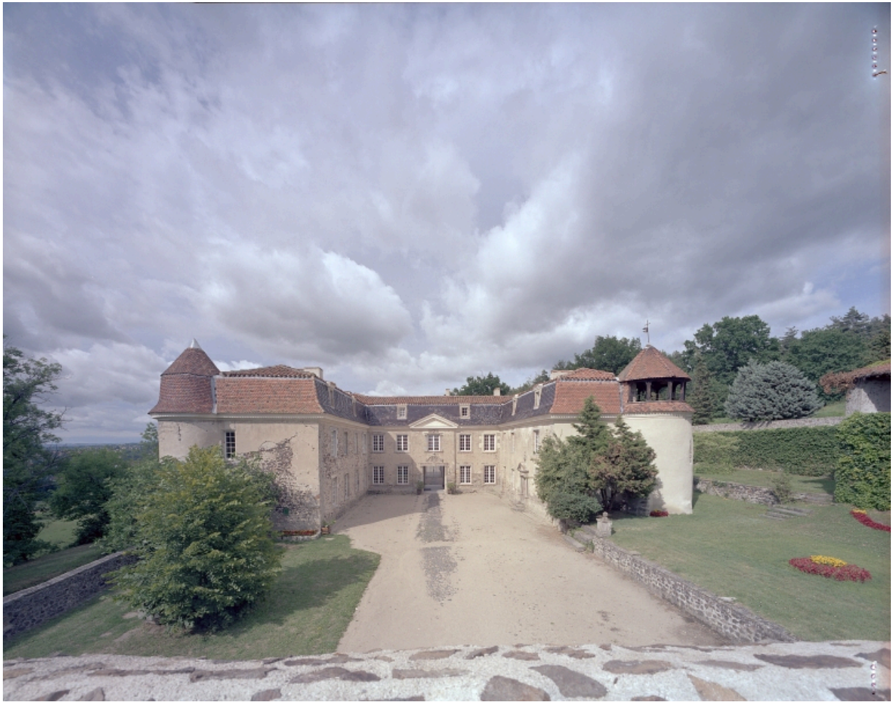
Vue générale de la cour d'honneur, du sud-est.
