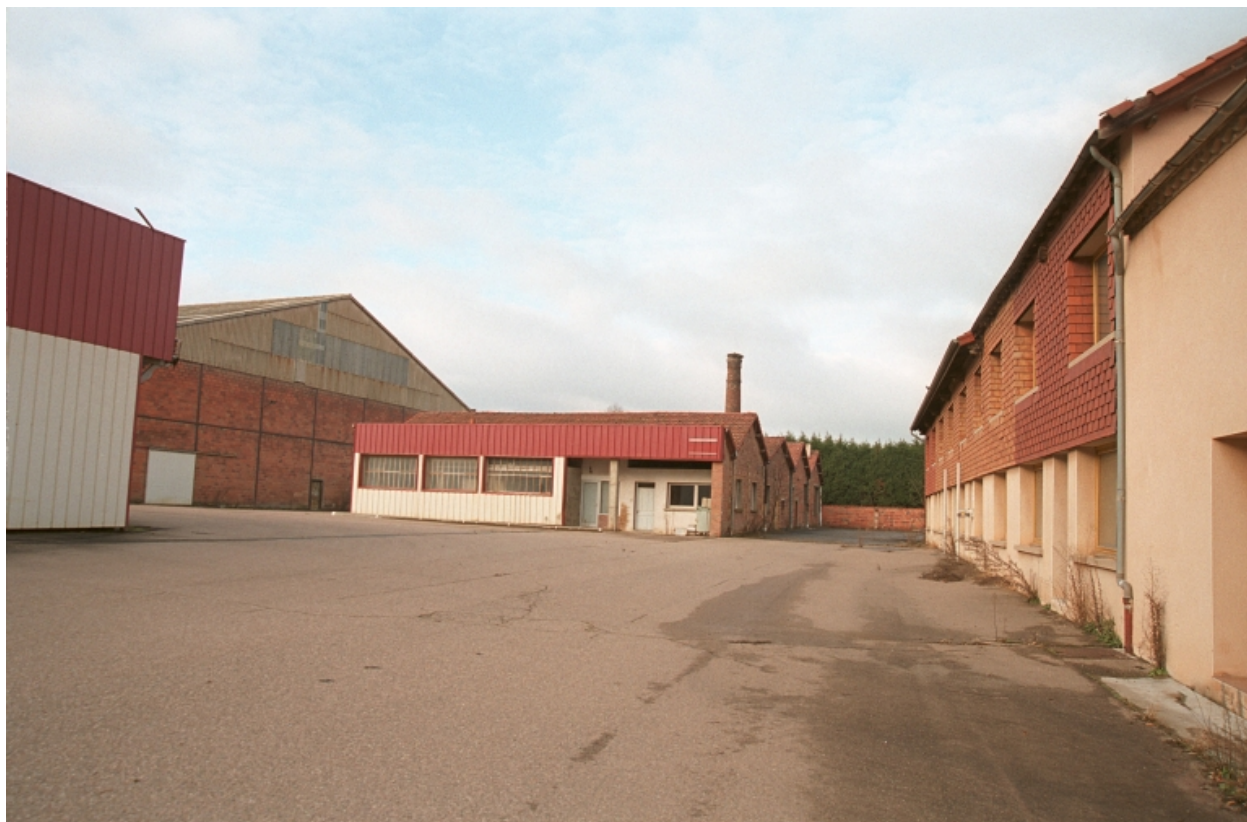
Vue d'ensemble de plusieurs bâtiments de l'usine.
