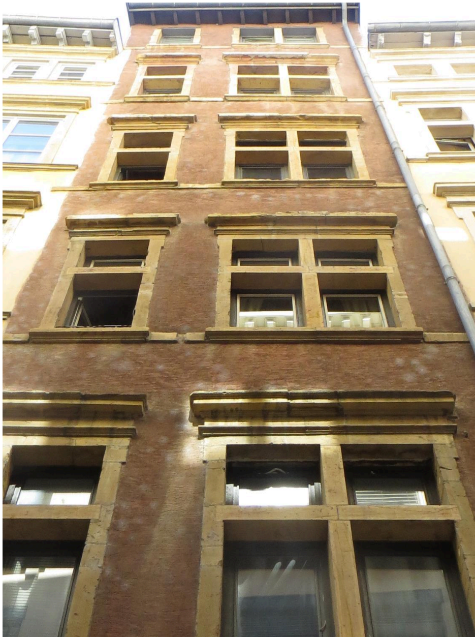
Elévation sur rue : les étages carrés
