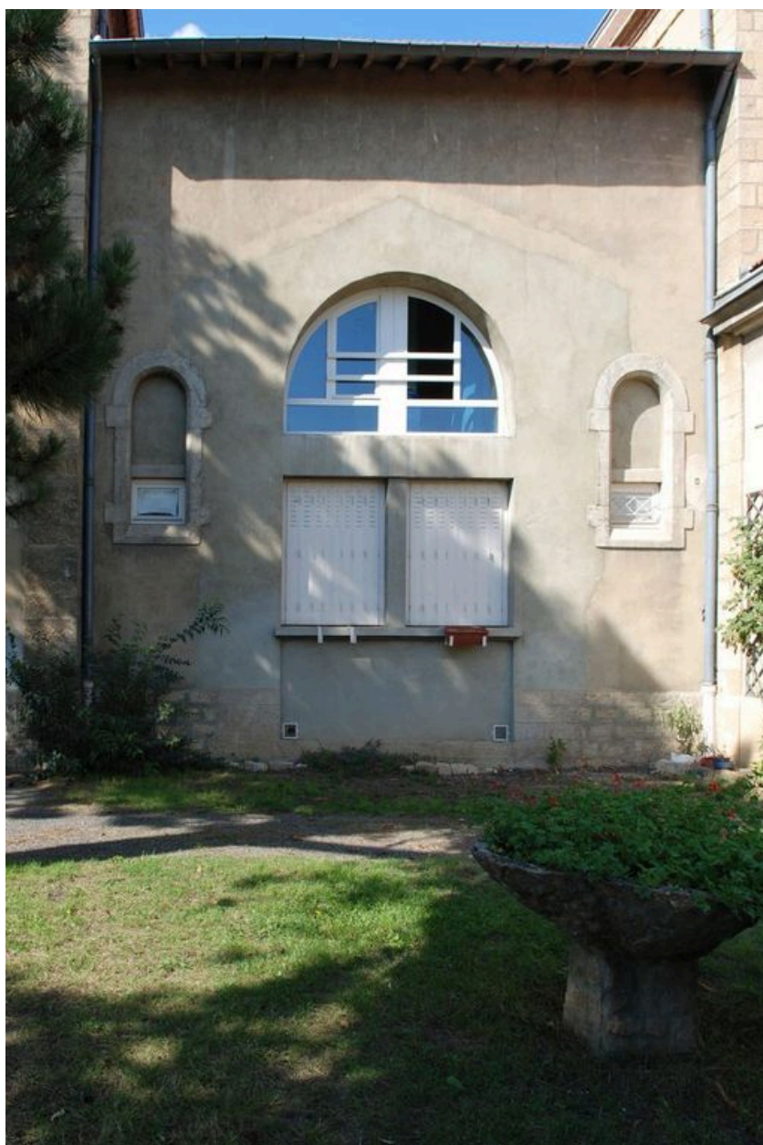
Bâtiment 320, façade postérieure (est) : traces d'ouverture
