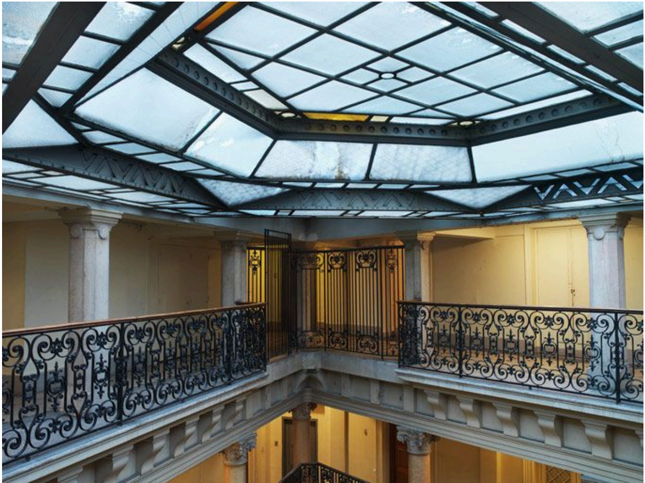
Vue de l'étage de combles et de la verrière.
