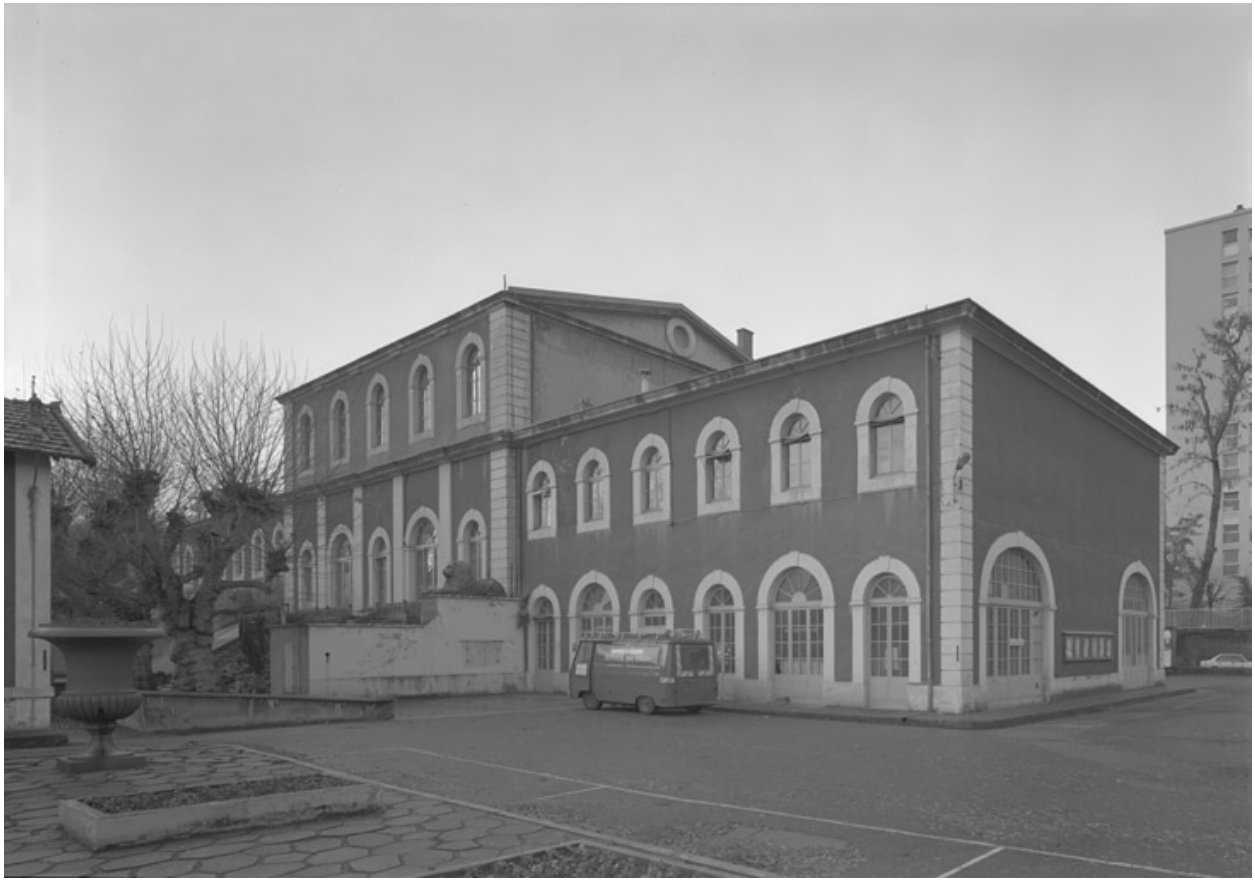
Vue générale du bâtiment des pompes à Cornouailles
