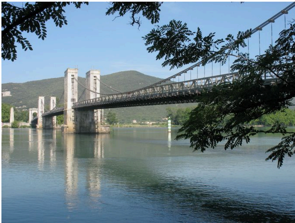
Vue générale du pont suspendu à piles multiples de Donzère (Drôme), dit pont du Robinet (1847), face aval, depuis la rive gauche
