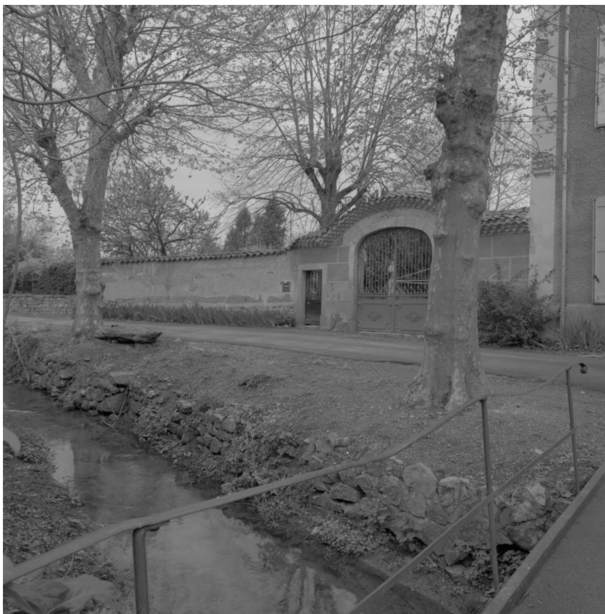
Vue générale du portail, de l'est.
