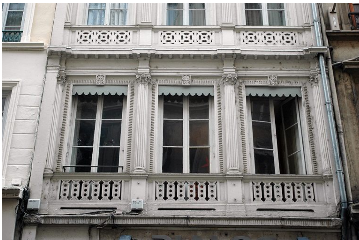
Elévation antérieure : le premier étage carré
