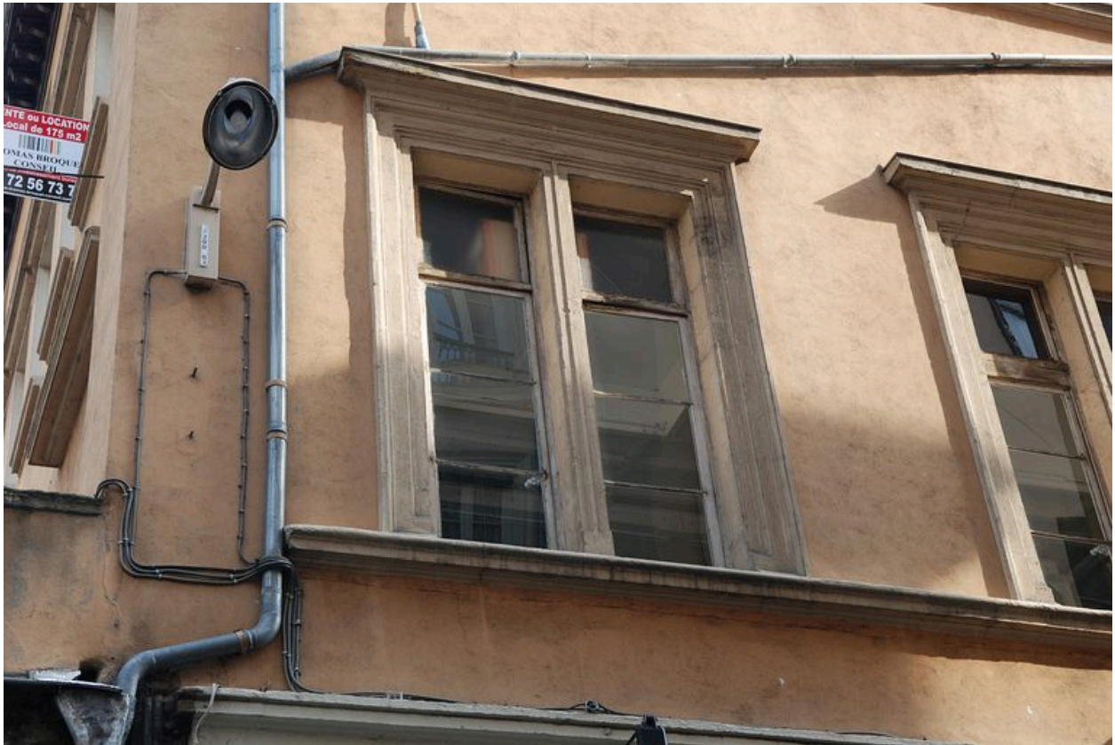
Elévation sud : 1er étage carré, encadrement de fenêtre
