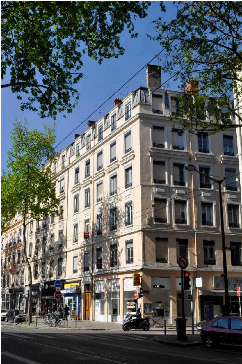
Vue prise du nord, élévation sur l'avenue Jean-Jaurès
