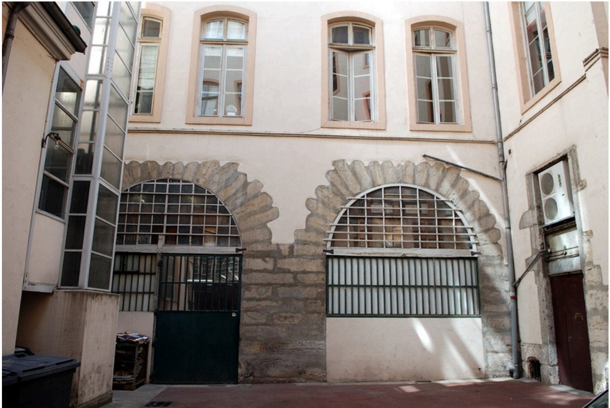
La cour : élévation nord, les premiers niveaux
