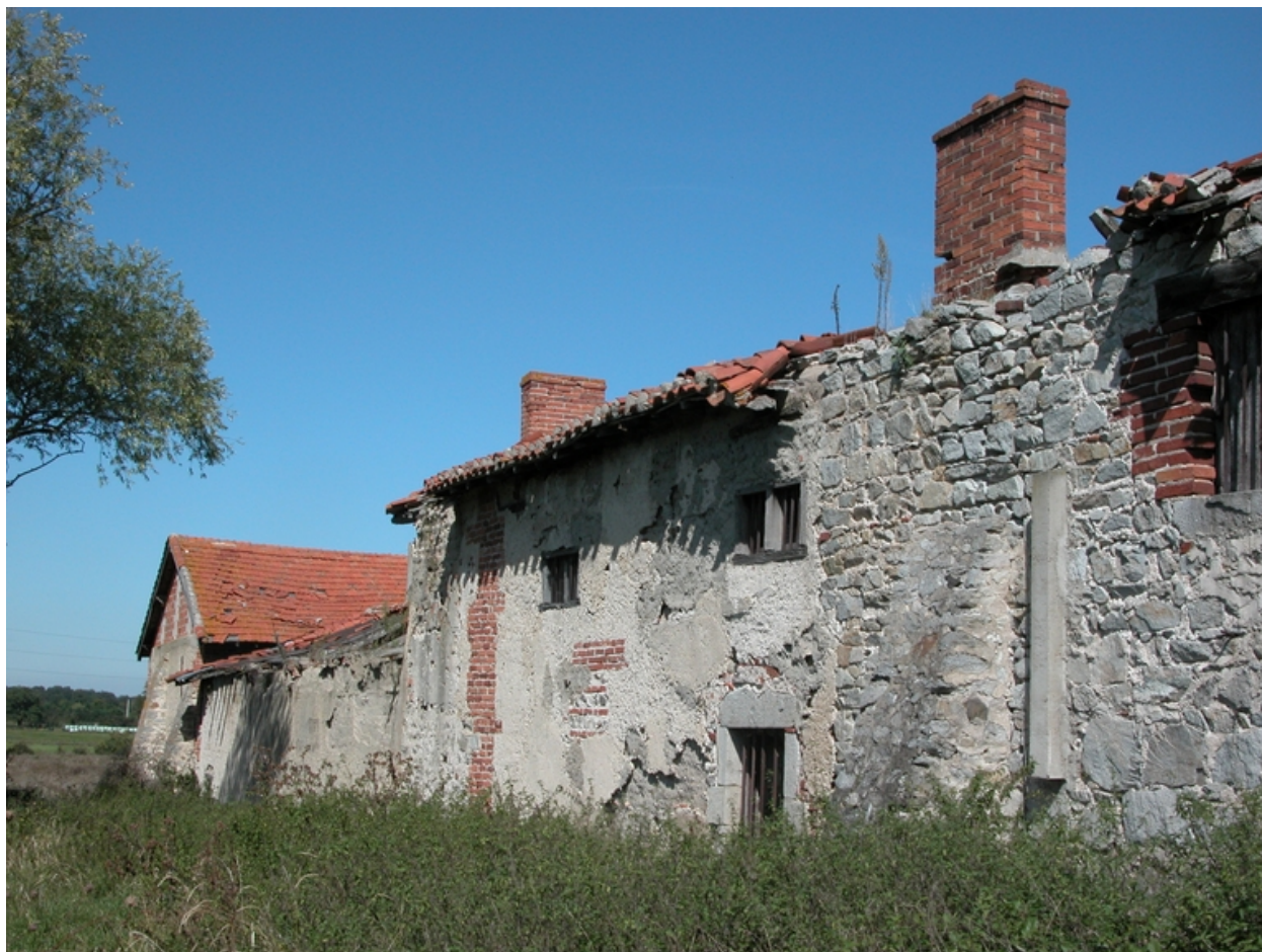
Vue de la partie sud du logis, depuis le sud-ouest.
