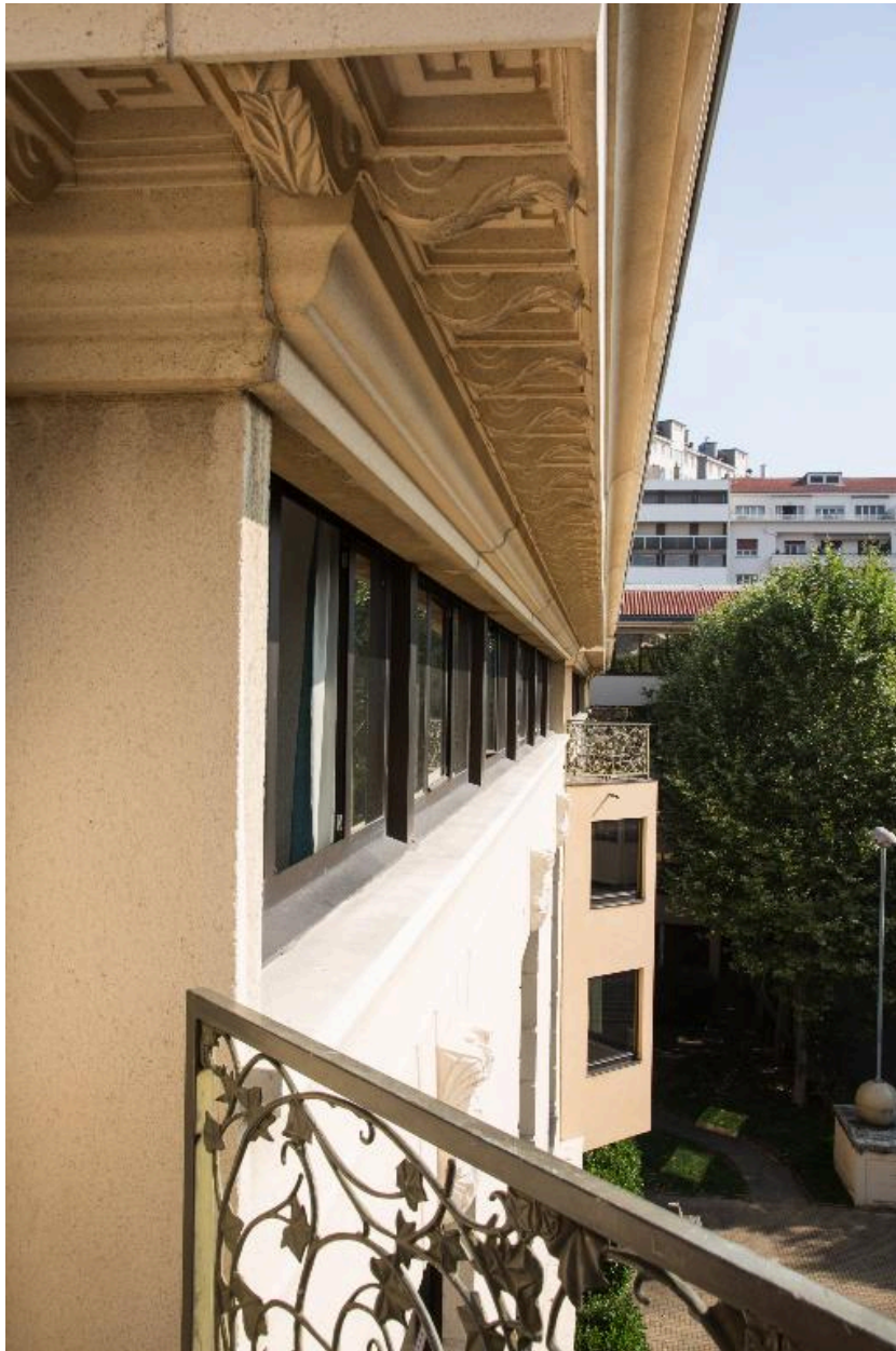
Vue sur le bâtiment depuis un balcon du quatrième niveau
