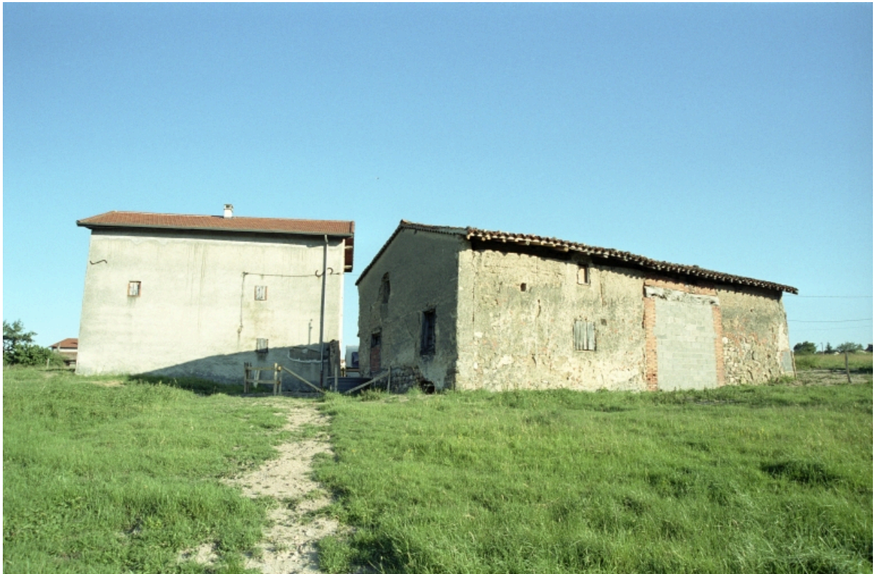
Marcilly-le-Châtel, la Garde (1987 A2 769), type A1. Vue générale depuis le nord.
