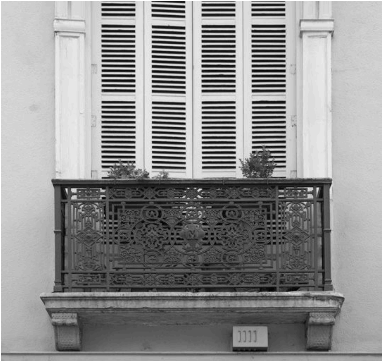
Elévation quai Saint-Antoine : premier étage carré, détail d'un garde-corps
