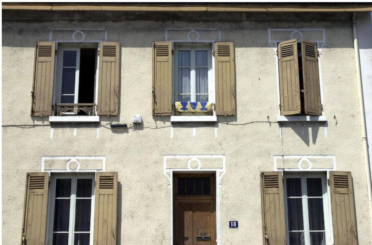
Détail du traitement de la façade
