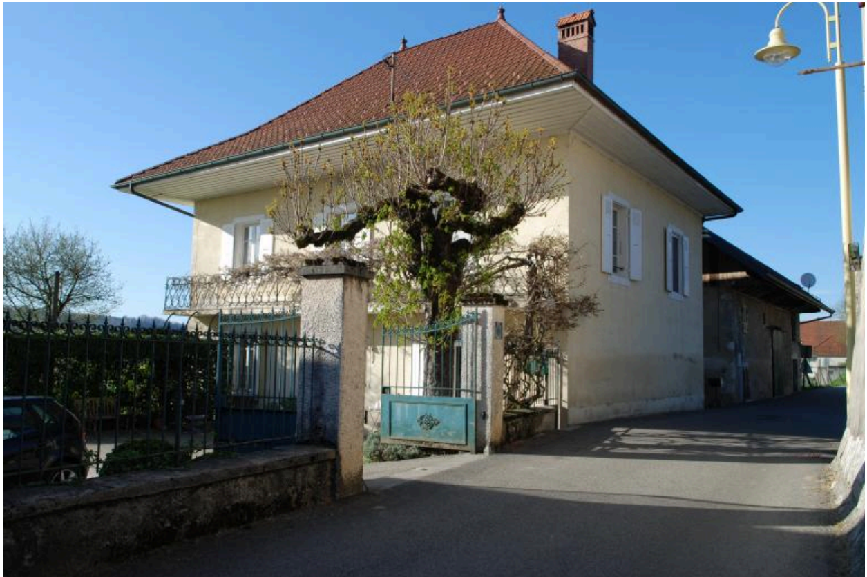
Vue d'ensemble de trois-quarts avant droit.
