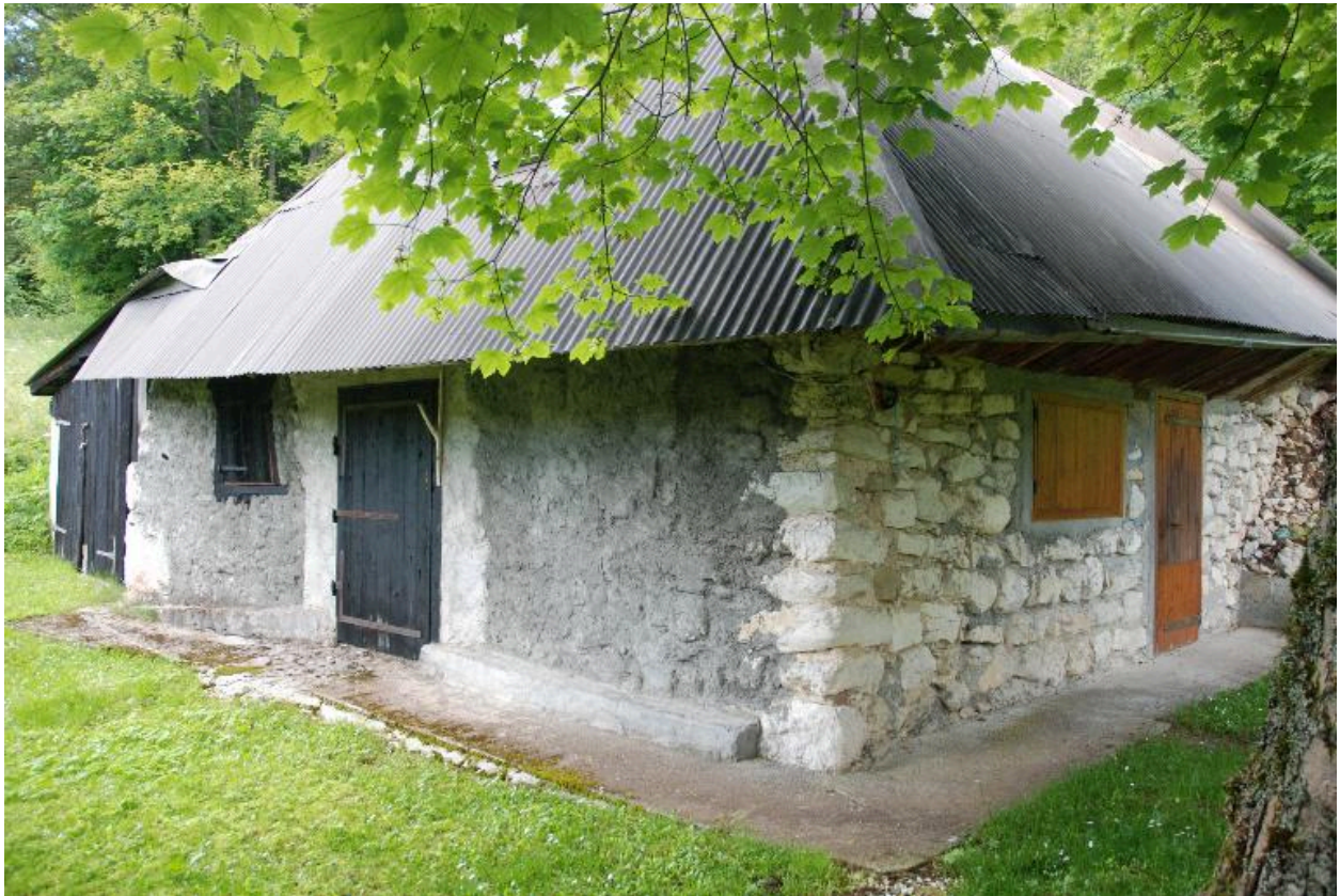
Vue d'un chalet (2016 G2 401) aux Chalets Ballan (non repéré).
