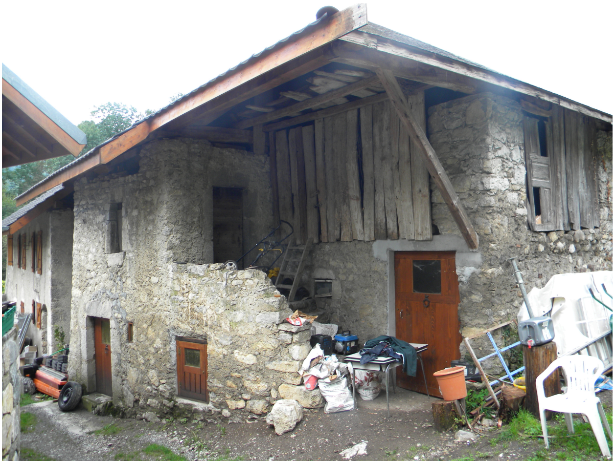
Vue du fenil au nord du bâtiment.
