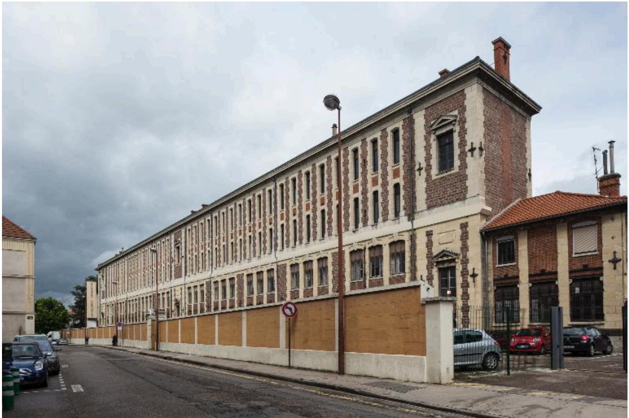
Bâtiment A. Façade sur la rue de Noélas
