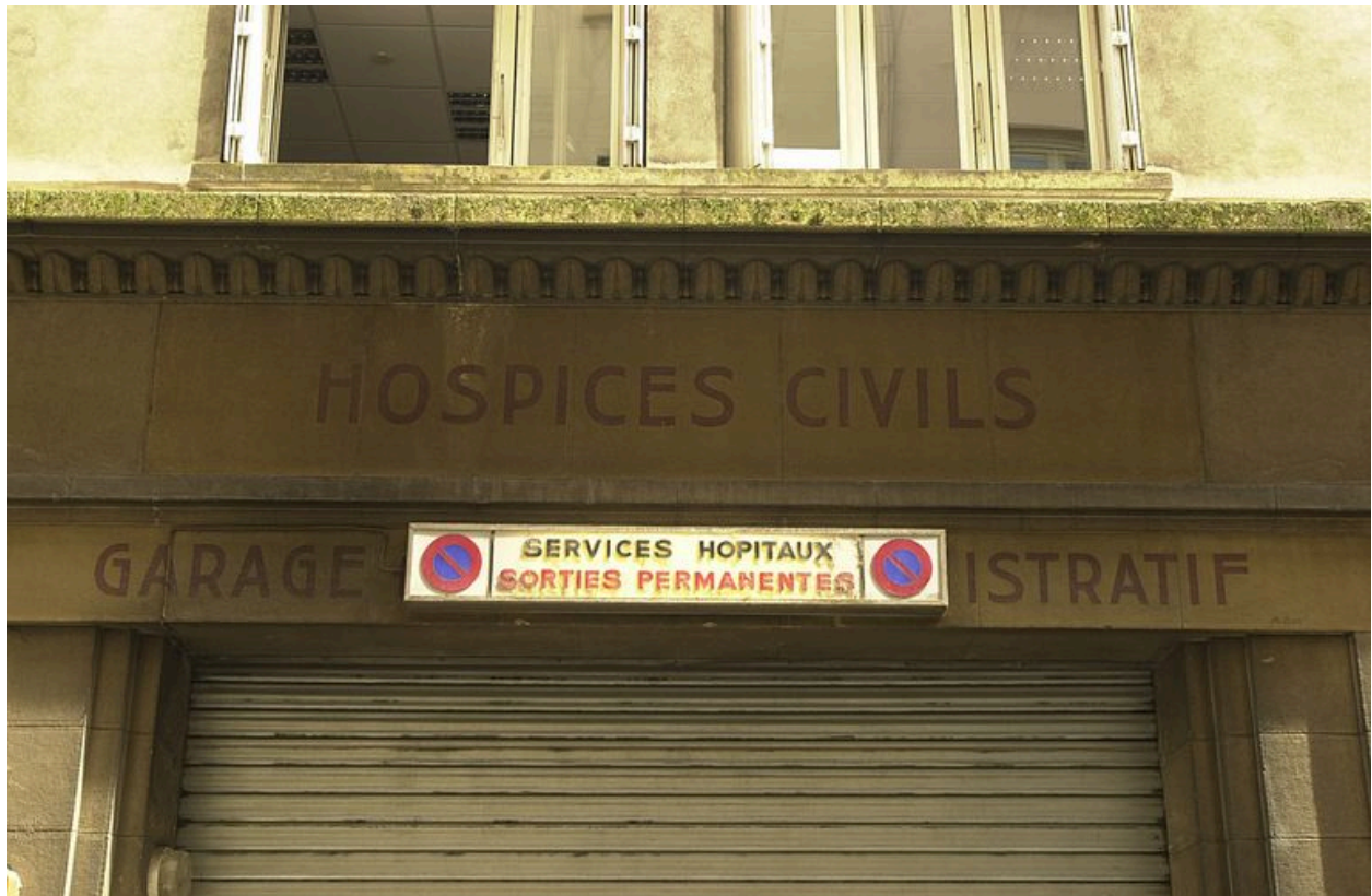
Garage n°5 rue de Savoie (détail de l'inscription)
