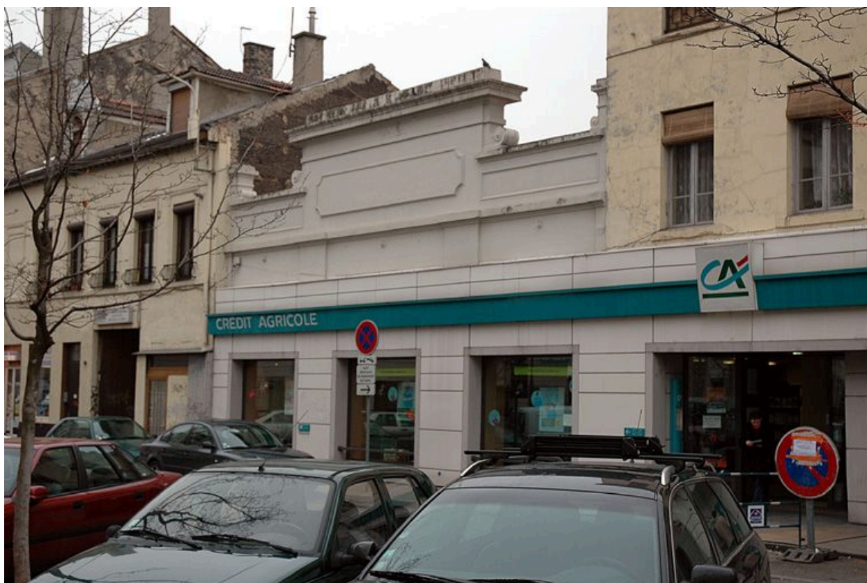
Vue générale du bâtiment sur rue
