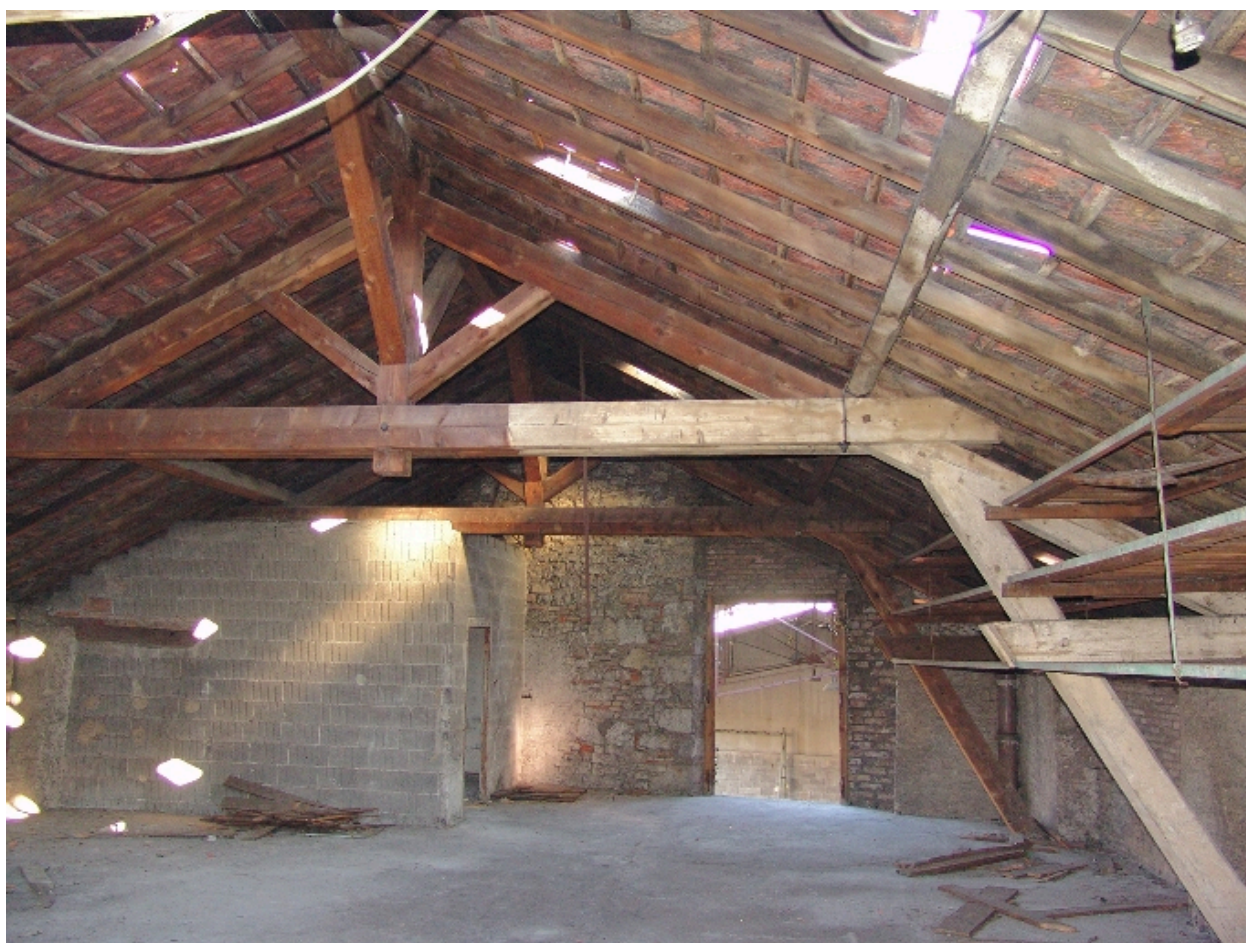
charpente en bois
