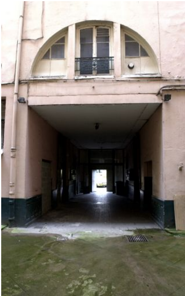
Vue du passage cocher depuis la cour
