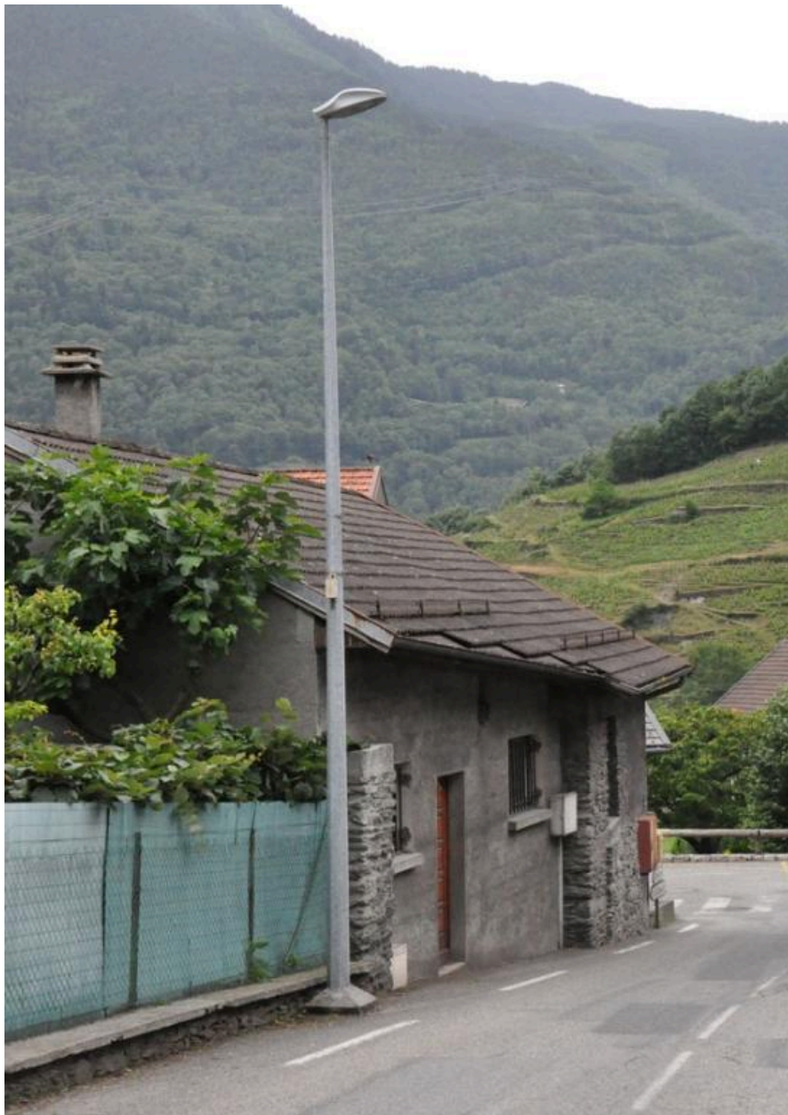
Façade nord-est du bâtiment.
