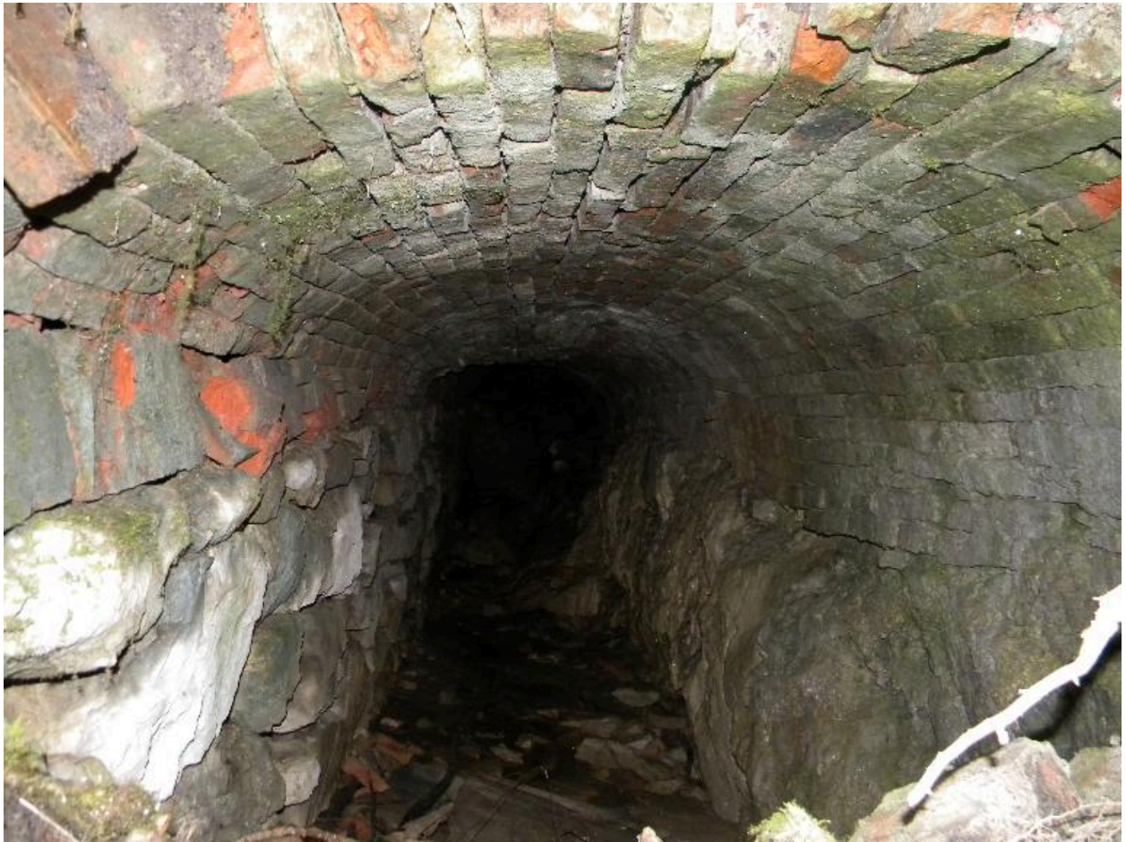
Intérieur d'une galerie voûtée en brique près du puits et servant de garde manger.
