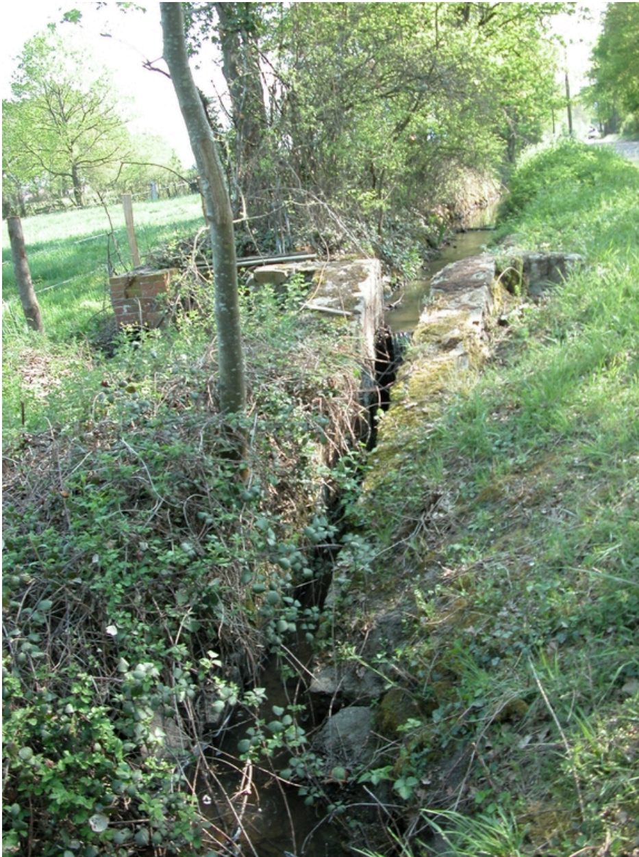
Artériole du canal du Forez à Chantegrelet (section 1997 AL).
