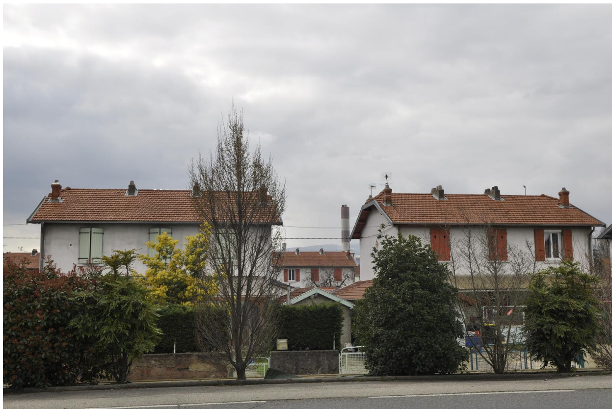
Deux maisons ouvrières des cités ouvrières de Roussillon
