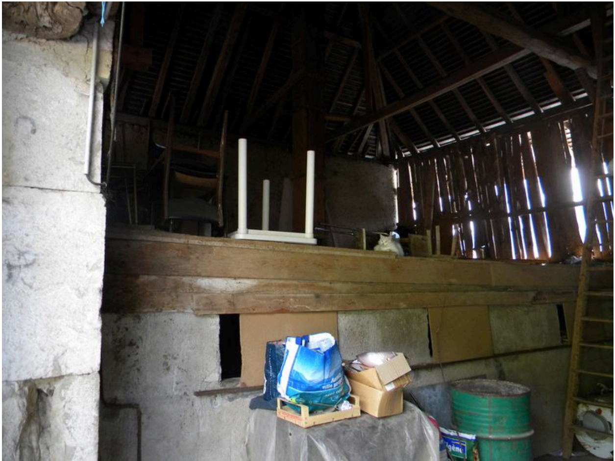
Vue intérieure de la grange et du mur de l'étable.
