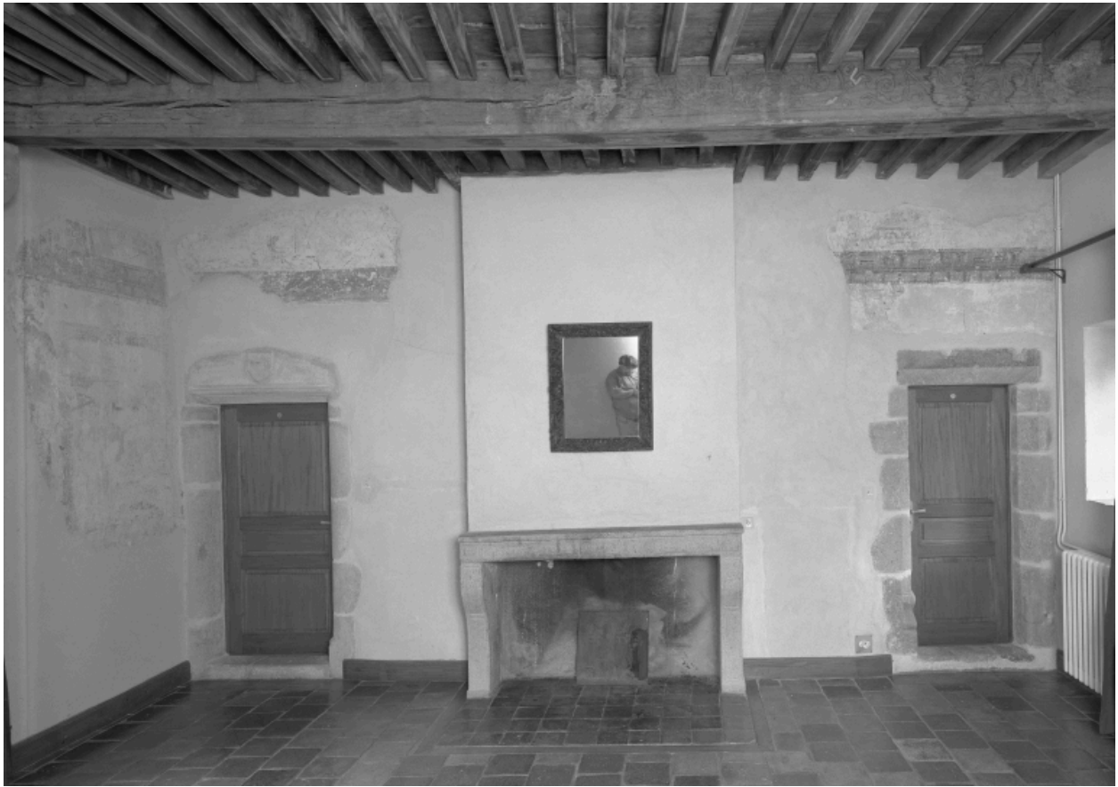
Corps de logis sud-ouest, premier étage, chambre dite de Jehan Papon : vue générale intérieure (peintures murales, cheminée).
