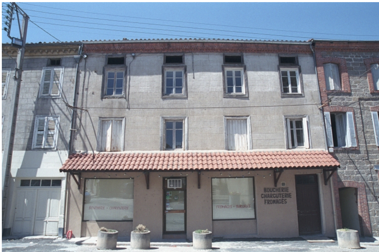
Au Bourg, maison avec commerce (1986 C2 724). Bâtiment avec enduit à faux appareillage et génoise. Vue d'ensemble de face donnant sur la place de l'église.
