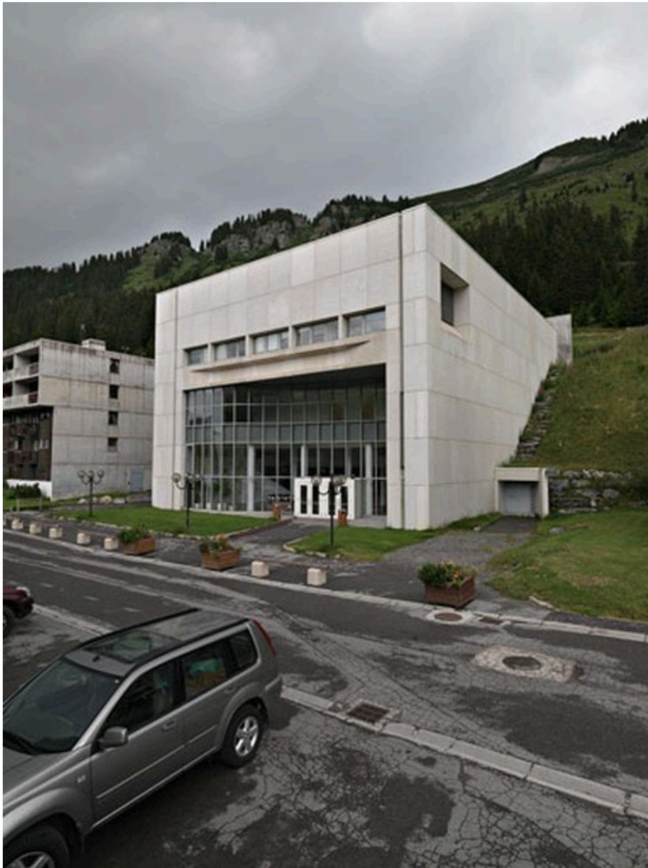
Vue depuis le sud-est
