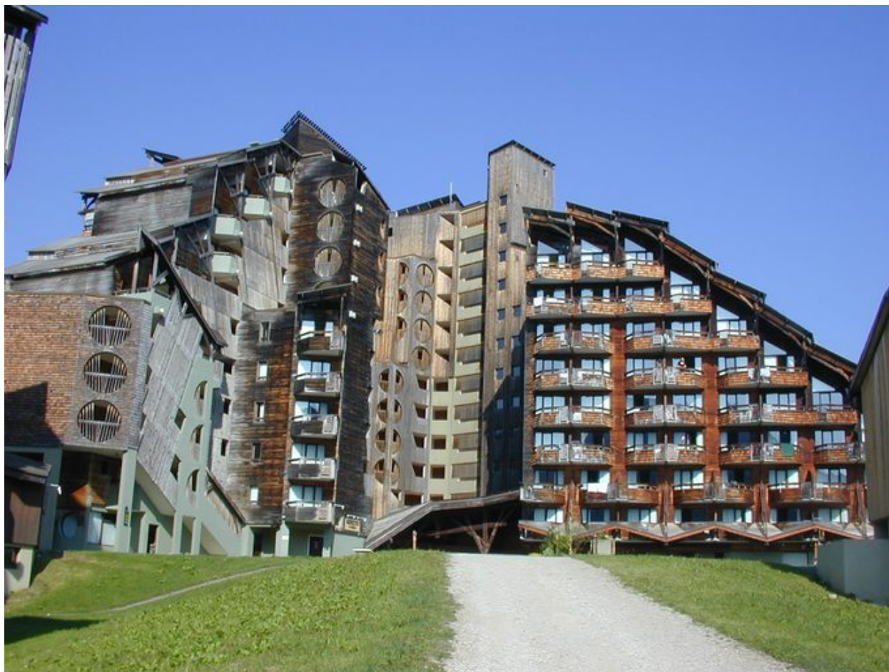
Vue depuis l'est, avec l'entrée de la résidence
