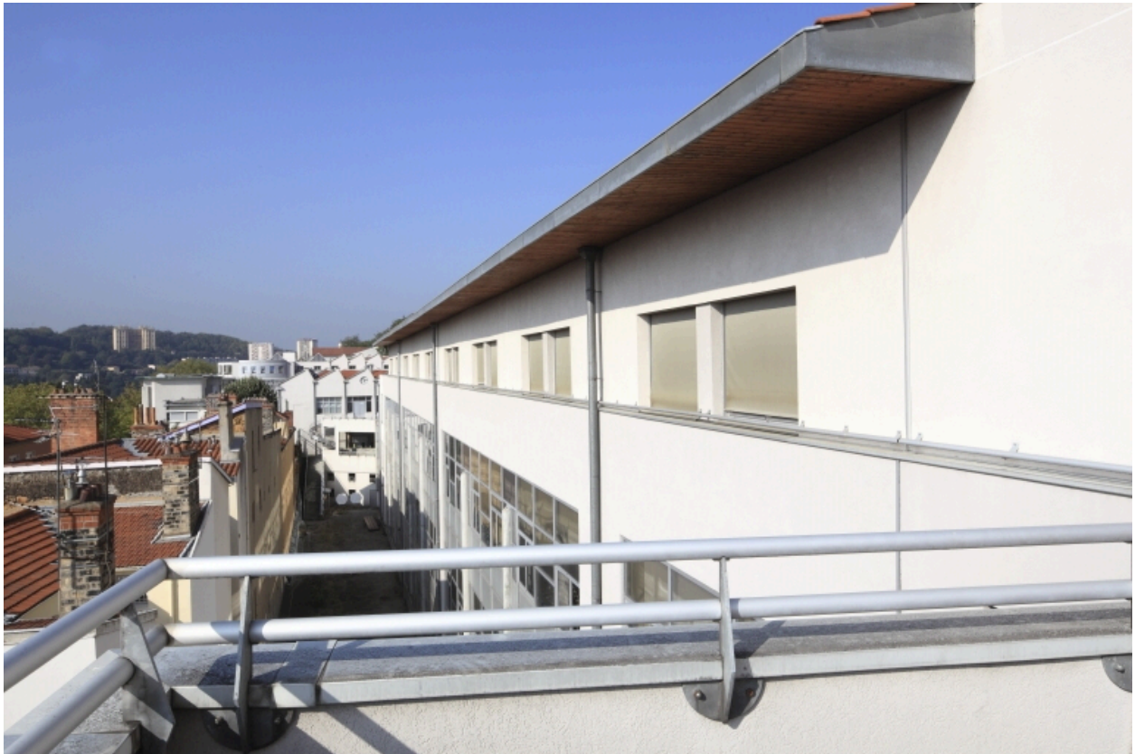
Terrasse du bâtiment des ateliers.
