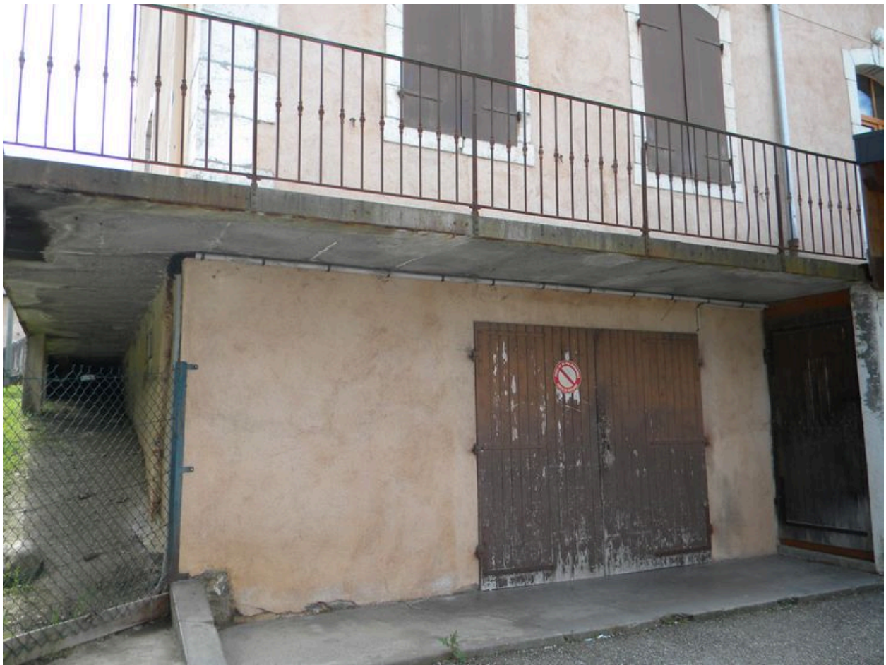
Vue de l'angle nord-est et le garage semi-enterré.
