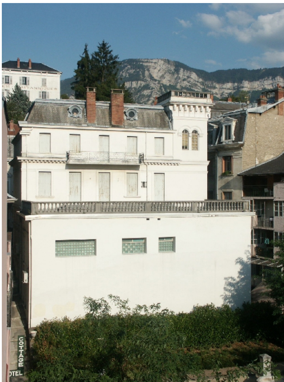
Vue de l'élévation postérieure
