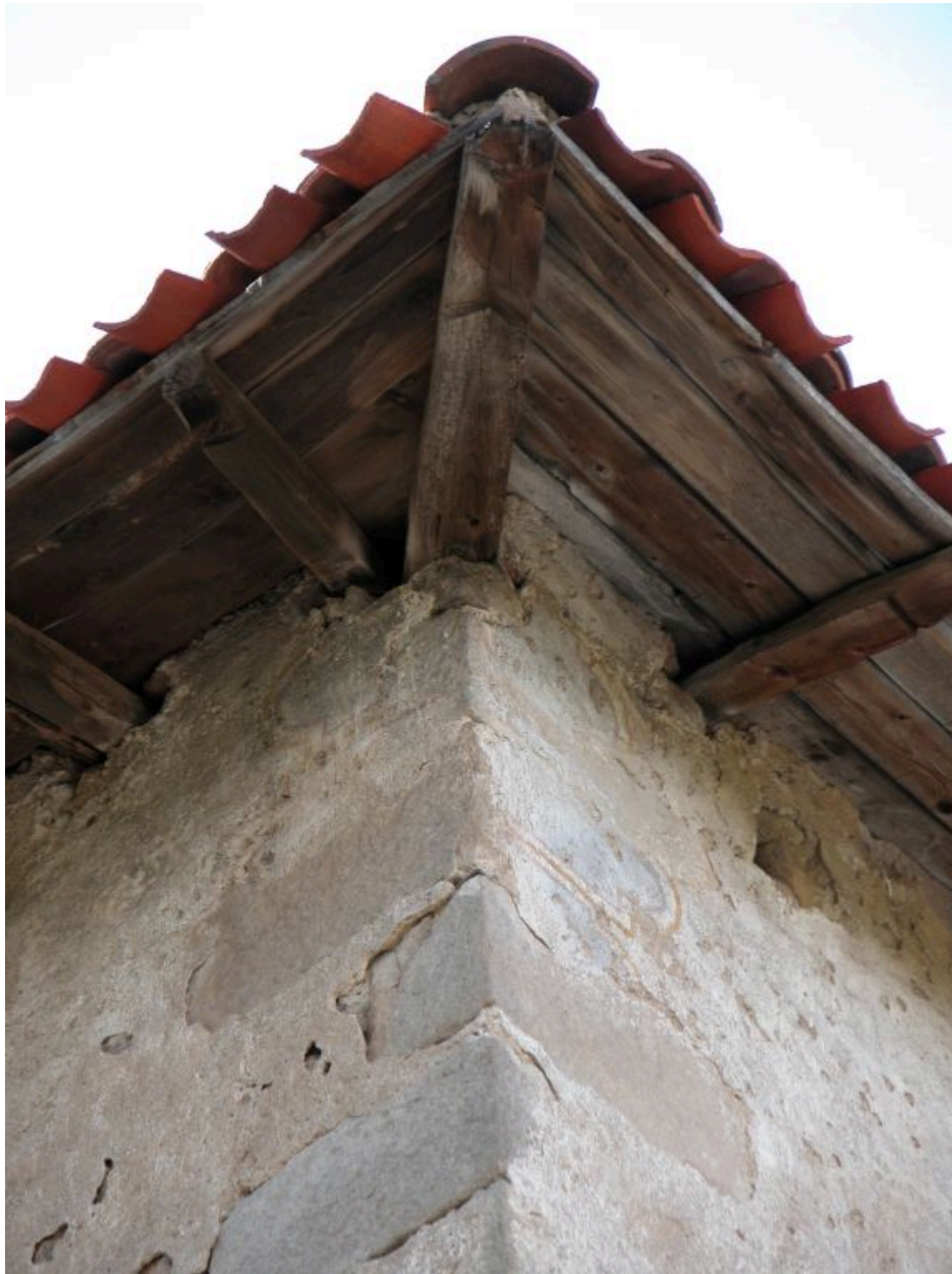
Corps de bâtiment nord de la maison forte, angle sud-ouest : détail du décor peint du chaînage d'angle
