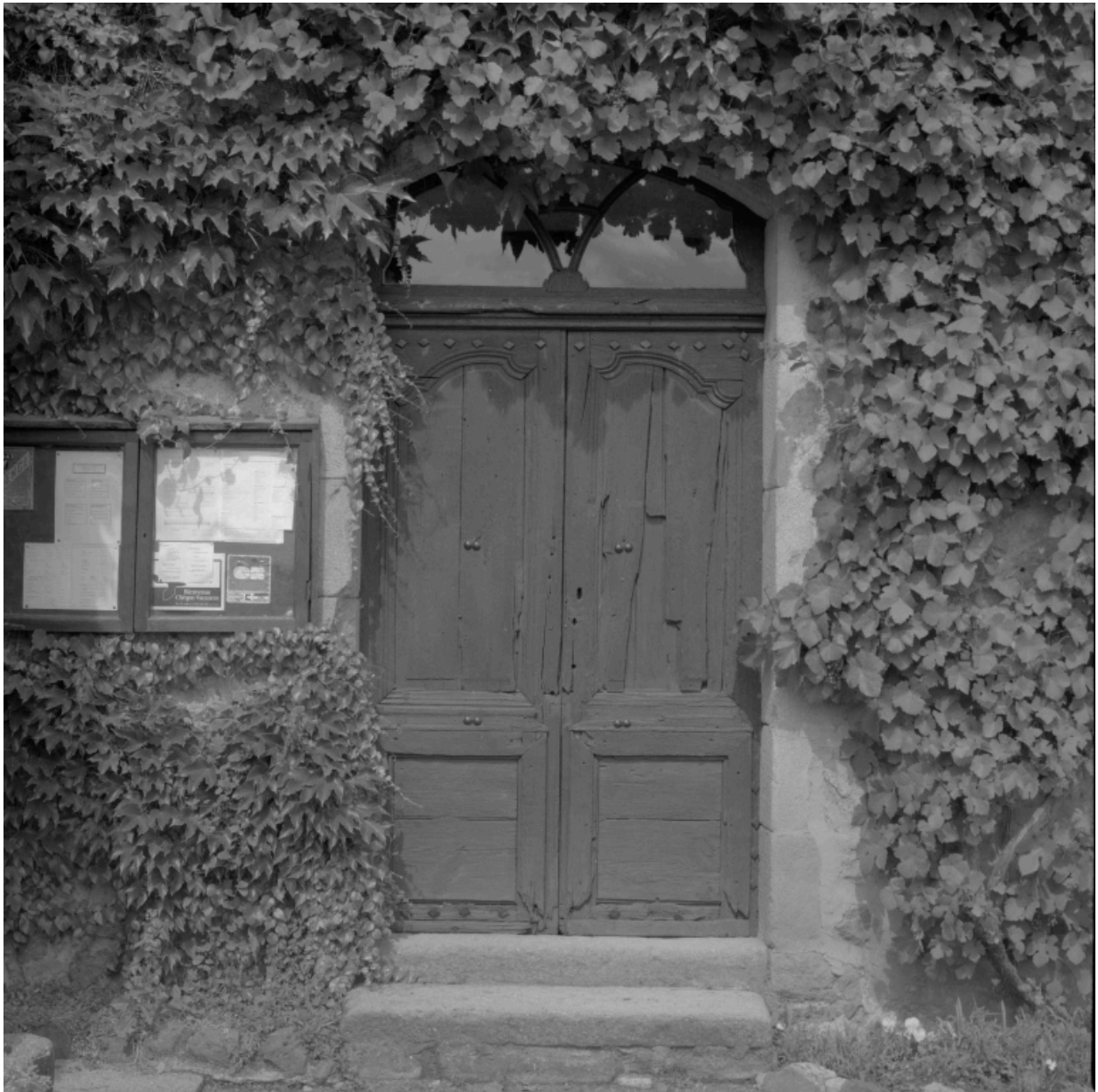
Détail de la porte d'entrée.
