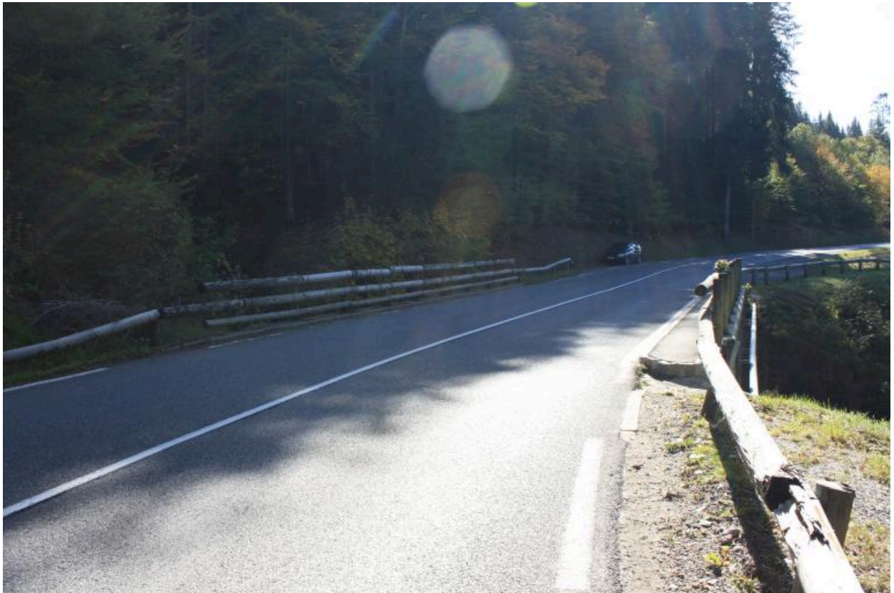
Pont des Ancarnes, chaussée et gardes-corps
