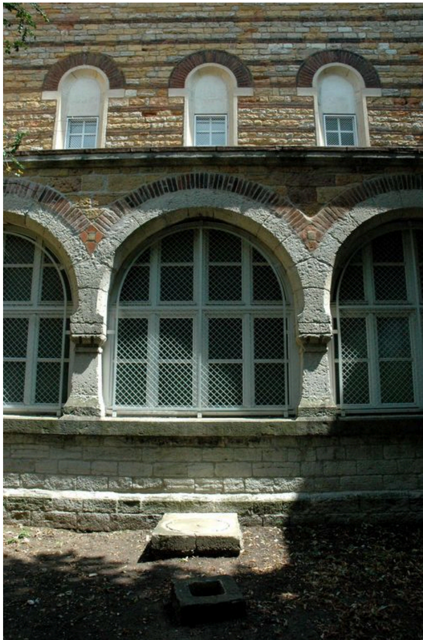
Elévation postérieure, galerie longeant l'ancien choeur des religieuses, détail d'une travée
