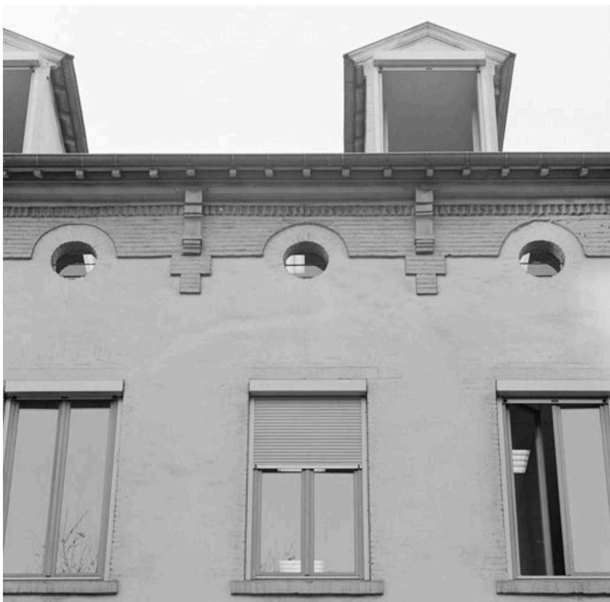
Elévation rue Vendôme : détail de la partie supérieure ornée d'une frise de briques
