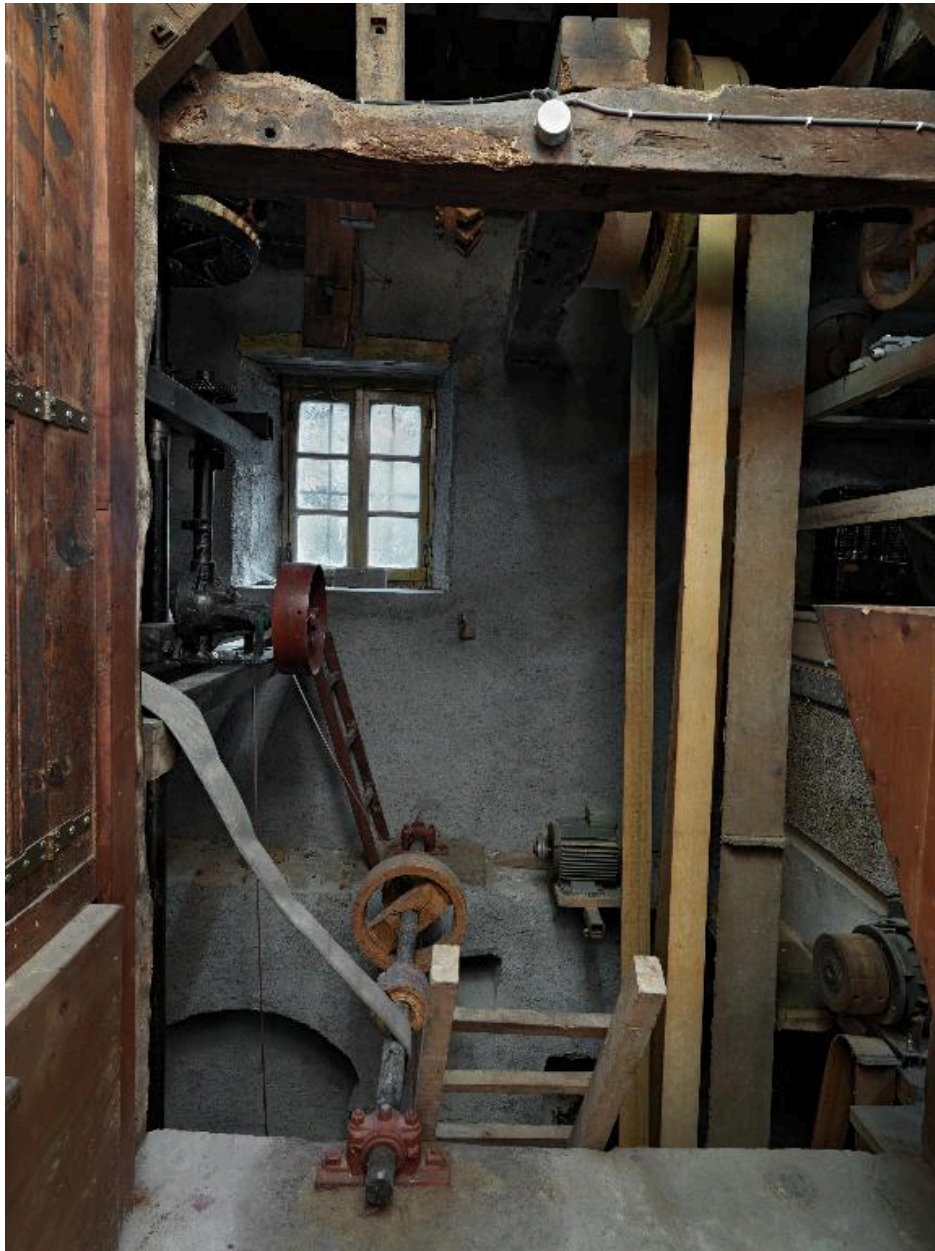
Etage de soubassement : transmission de la roue hydraulique.
