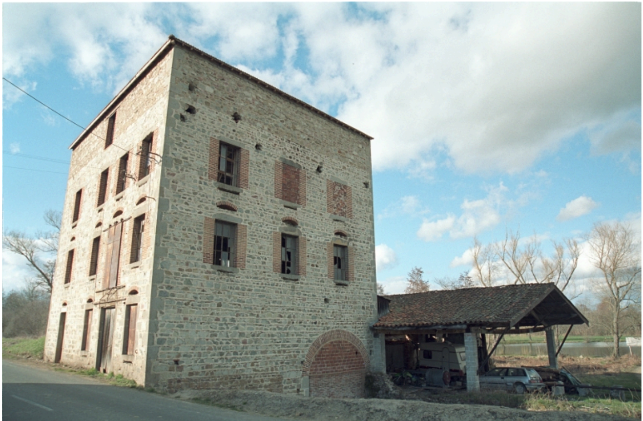
Vue d'ensemble des façades sud et ouest du moulin.
