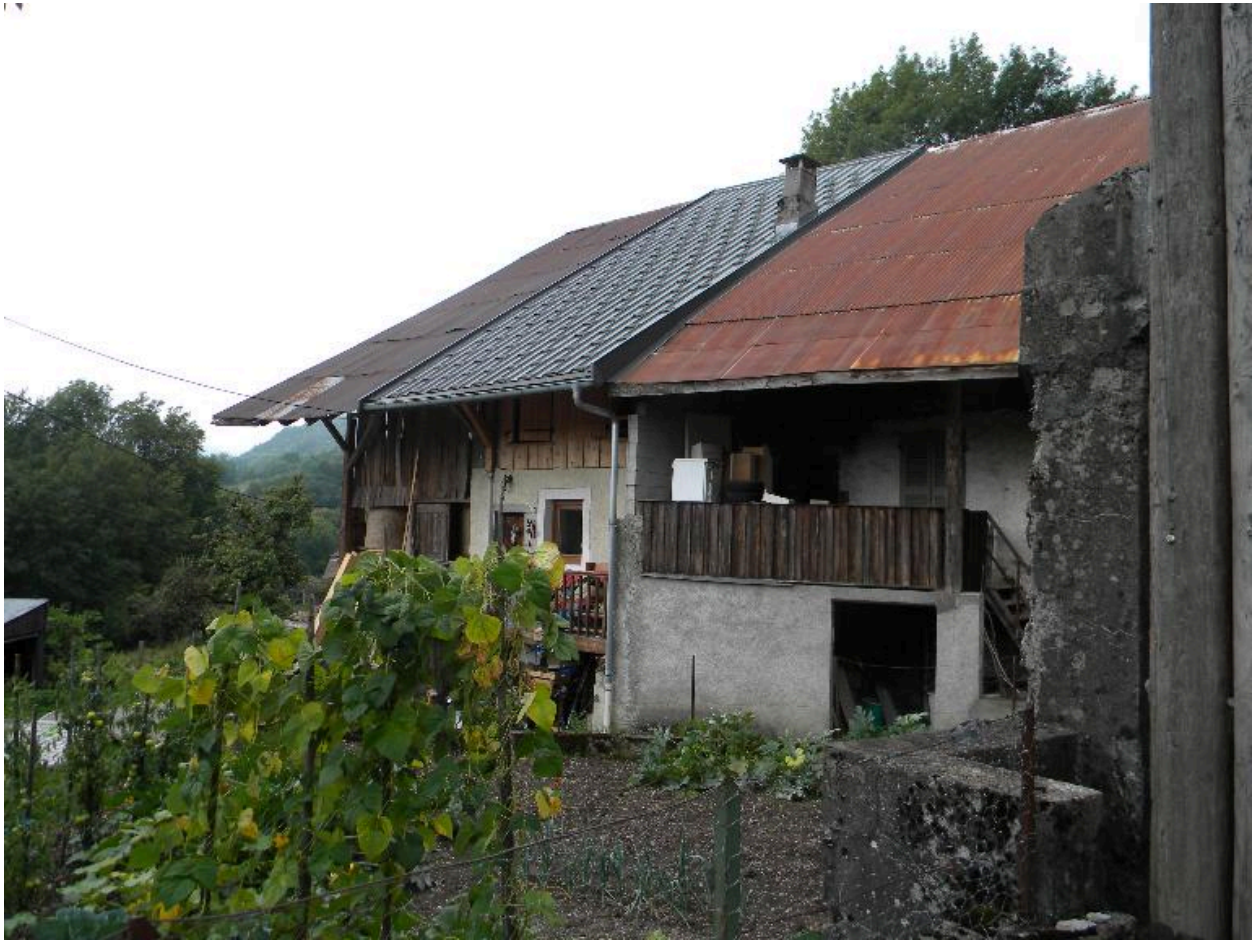
Vue des façade sprincipales d'un alignement de fermes. (2008 F10 1286, 1287, 1288)
