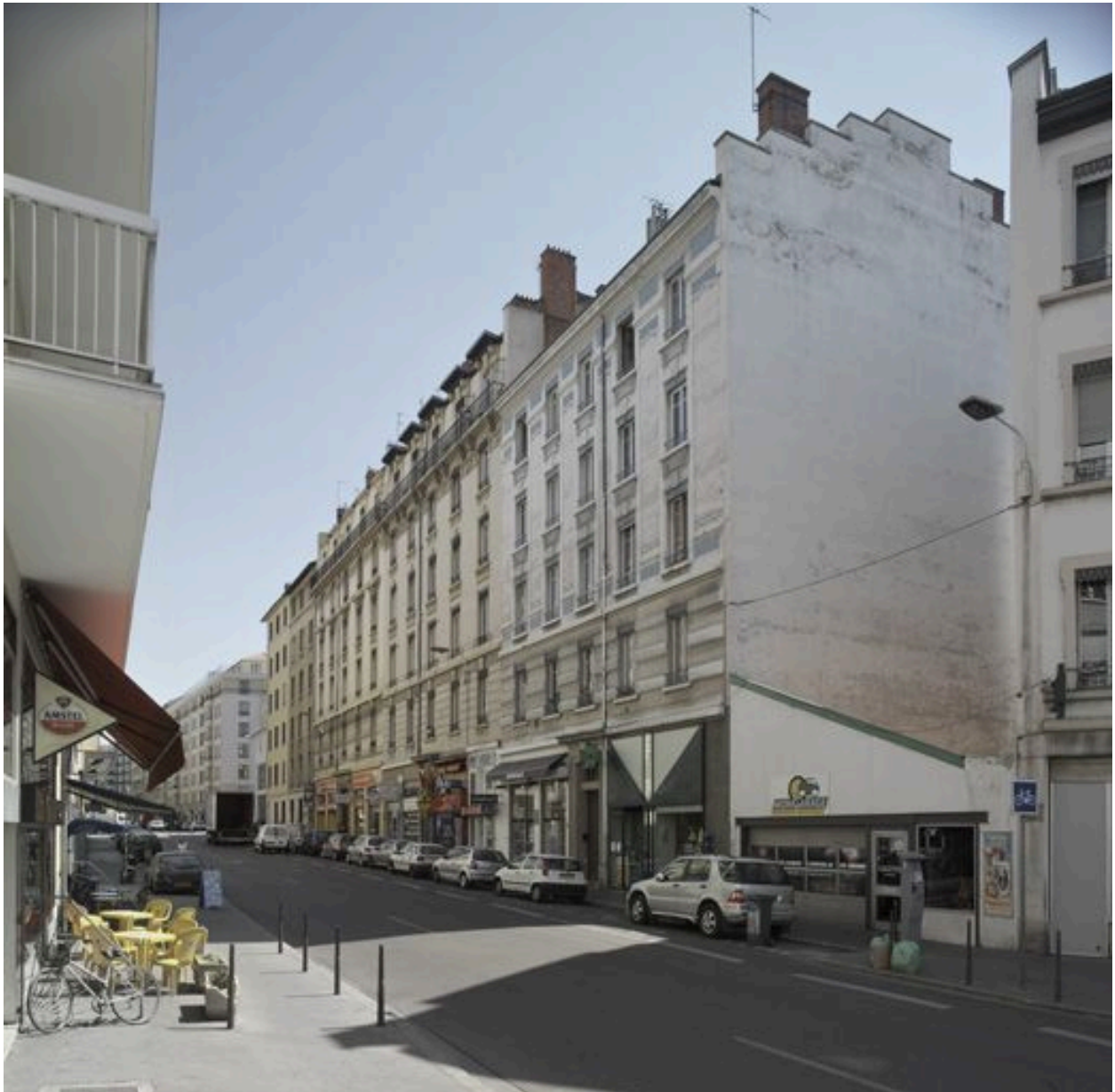
La grande rue vers l'est, à la hauteur du n° 204
