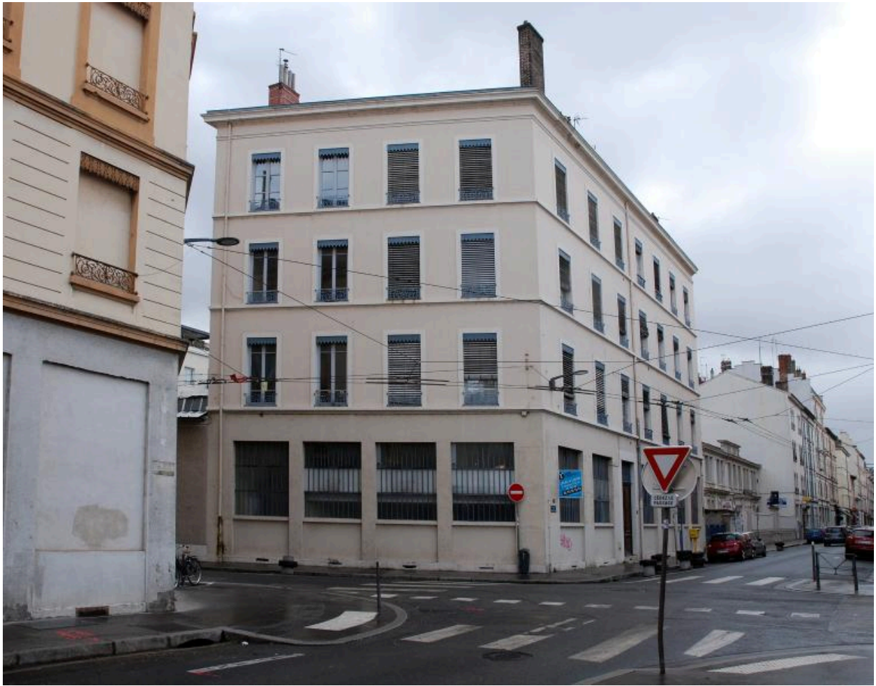
Vue générale de l'immeuble
