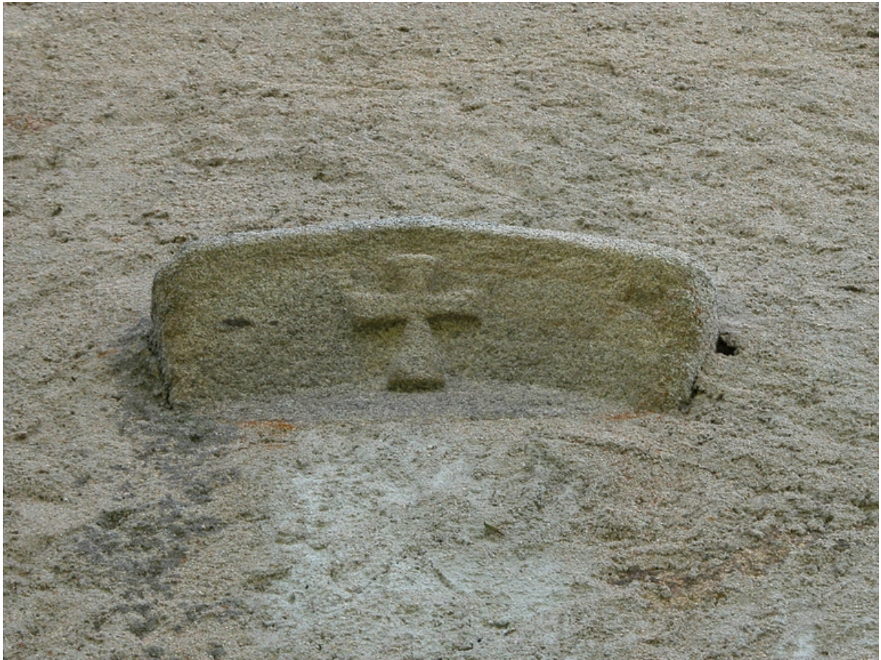
Détail du fragment de corniche en granite en remploi dans le pignon de la grange-étable.
