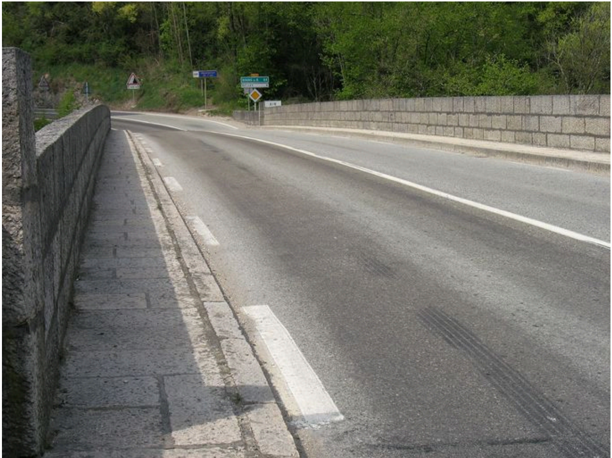
Vue de la chaussée
